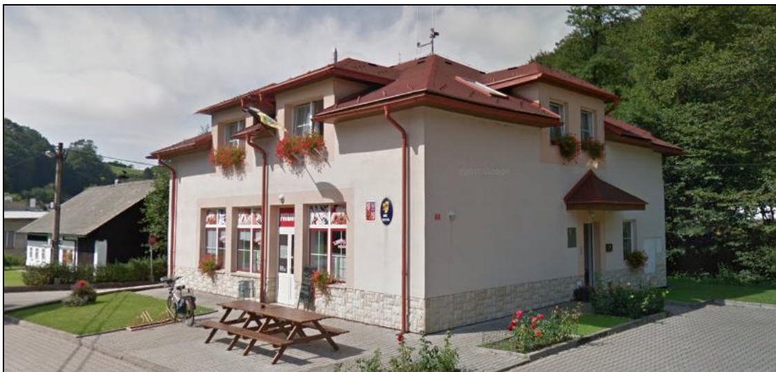
Obrázek 30: Budova obecního úřadu v Suchém Dole
